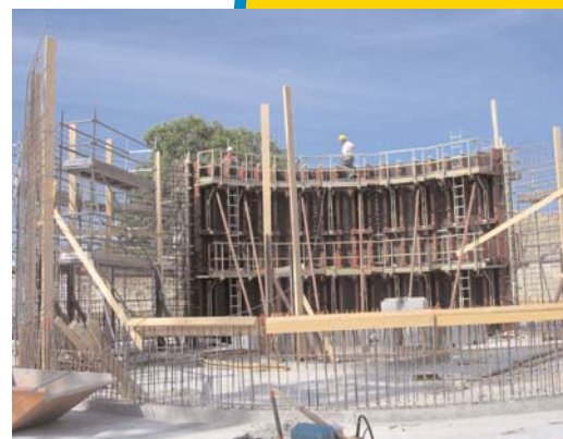
Construction de la station d'épuration de Gunstett
