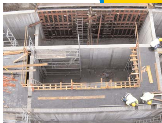
Construction de la station d'épuration de Dieffenbach-lès-Woerth
