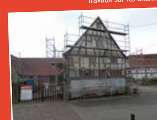
Remise en état des façades
