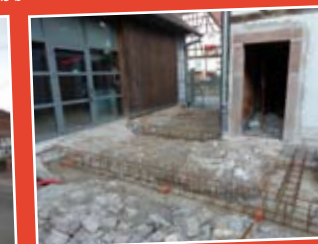
Fondations nouvel accueil
