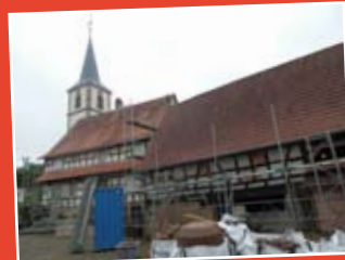
Travaux sur la grange
