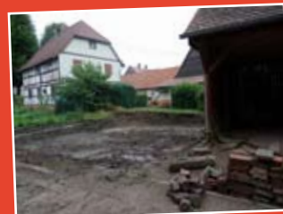
Emprise de la future nouvelle chaufferie
