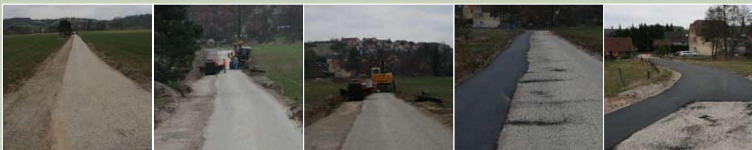
Réalisation de l'itinéraire cyclable vers Oberdorf-Spachbach
