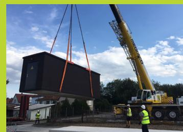
Pose d'un nœud de raccordement optique
