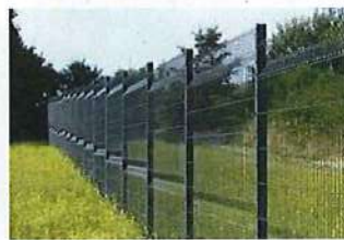
Pose d'une clôture
