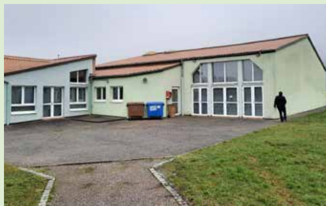
Toiture de la salle de Goersdorf
